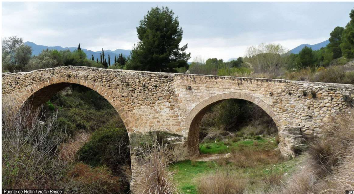
Puente de Hellín / Hellin Bridge
